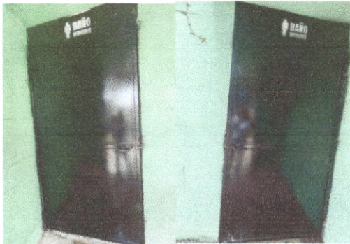
FOTO 3: Sustrucción de puerta
