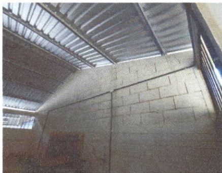
FOTO 5: Reparación de cableado Electrico
