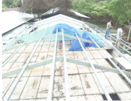
FOTO1: Sustrucción de lámina, por lámina troquelada o acanalada aluzinc calibre 26
